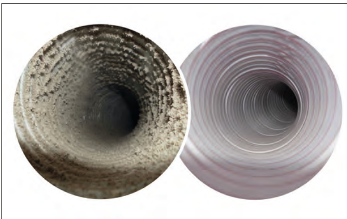
Lüftungen regelmässig pflegen: Lüftung vor (links) und nach der Reinigung (rechts).
