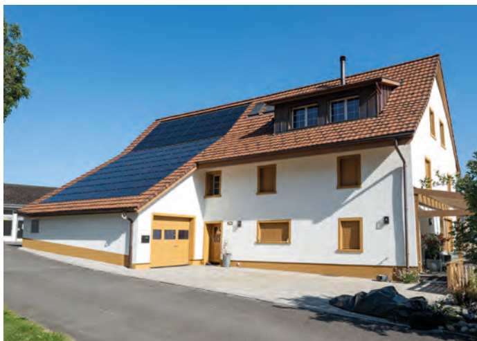
Dachsanierung mit Solar-Indachanlage in Leibstadt (AG).
