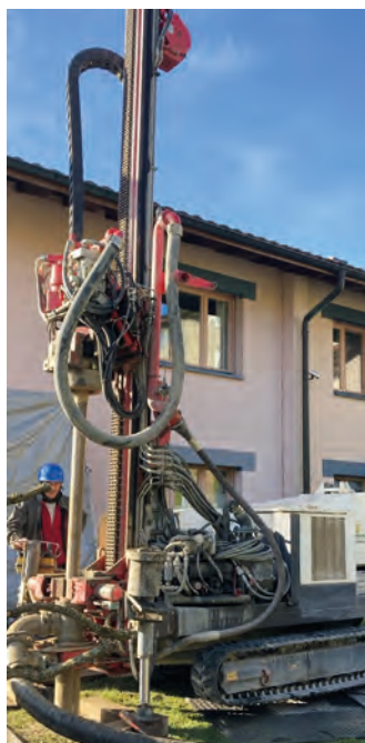
Erdsondenbohrungen mit dem kleinsten Bohrergerät der Schweiz.
